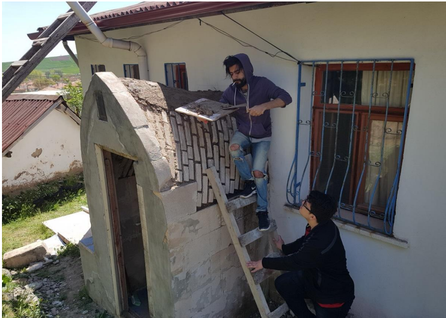
Figure 16. ODTÜ öğrencileri gazbeton ile inşa edilen Nubian tonozu toprak ve yağ karışımı ile hazırlanan sıva harcı ile sıvarken. (18kekc0253)
