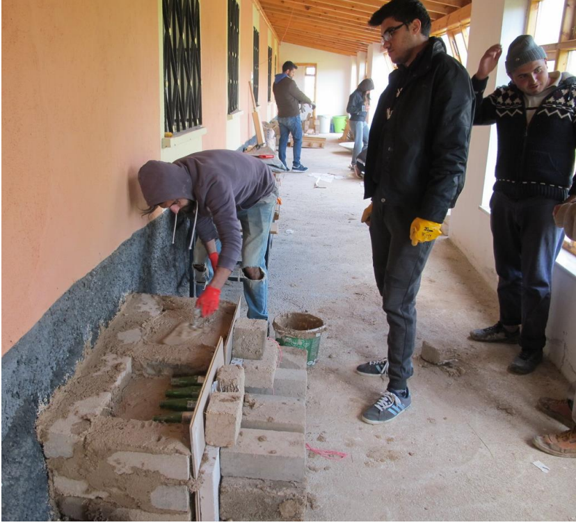
Şekil 21. Toprak, gazbeton blokları ve geri dönüştürülmüş cam şişelerden yapılmış bank. (18kekc0216)
