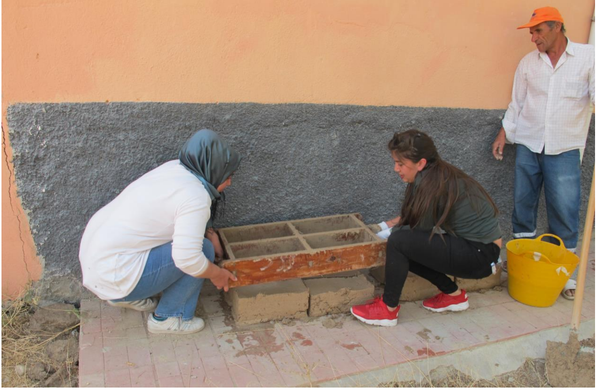
Şekil 29. Ahşap kalıplar ile kerpiç tuğla üretimi. (18kekc1133)
