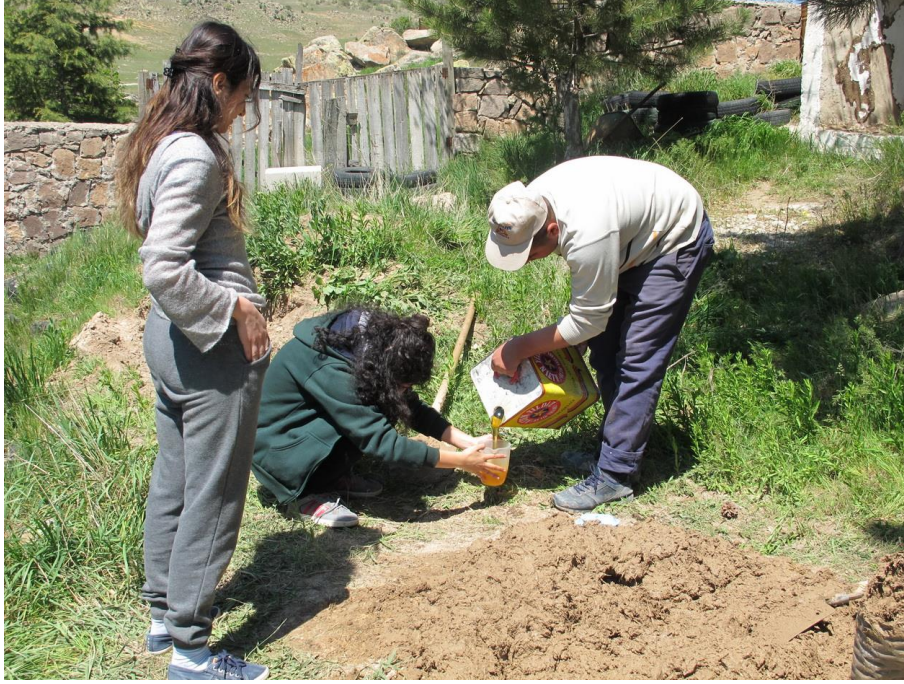
Şekil 15. Toprak sıvaya, dayanımının artırılması amacıyla yağ ilave ediliyor. (18kekc0241)
