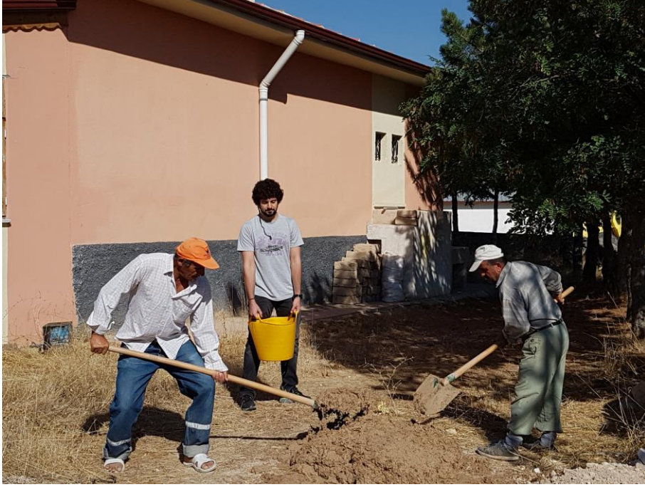
Şekil 10. Köylüler ve proje asistanı öğrenciler için toprak harç hazırlarken. (18kekc1003)
