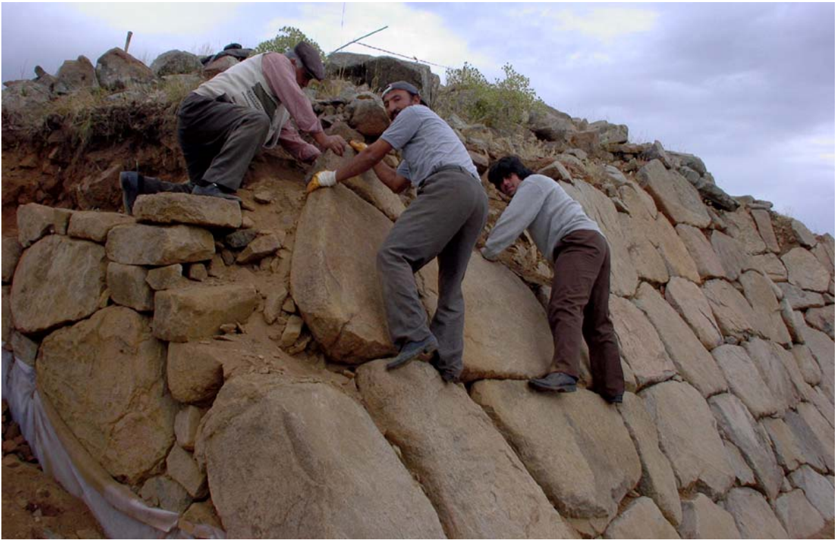
Şekil 47: Taş kaplı eğimli yüzeyi ( glacis ) oluşturan taşlardan bazıları yeniden özgün konumlarına yerleştirilerek kışın düşmeleri engellenmiştir. Kapı iç geçidinin özgün zeminini korumak için jeotekstil serildikten sonra üzerine moloz taştan bir dolgu yapılmıştır. (02dpjv5610)
