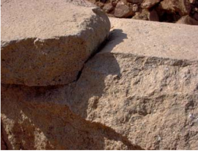
Şekil 56. Granit ortostatın üst yüzü, daha ince taşlardan oluşan bir harpuşa sırasının oturtulması için kesilerek şekillendirilmiştir. Yoğun ve yüksek ısıli yanma sonucu taşların yüzeyleri kırılarak ayrılmıştır. (03dpjv5123)
