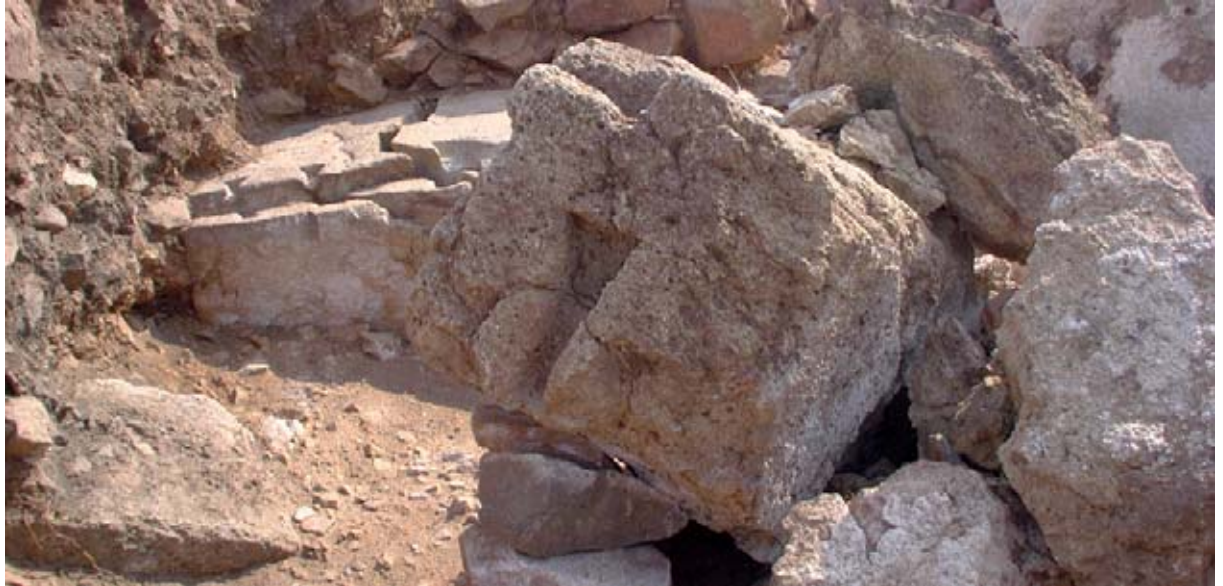
Şekil 19. Düşmüş konglomera blok iki adet kenet deliğine sahiptir ve sol üstteki eksiktir. Şekil 18'de görülen granit kesme taş blok burada arkadaki kule duvarının içinde insitudur. (04dpjv2215)
