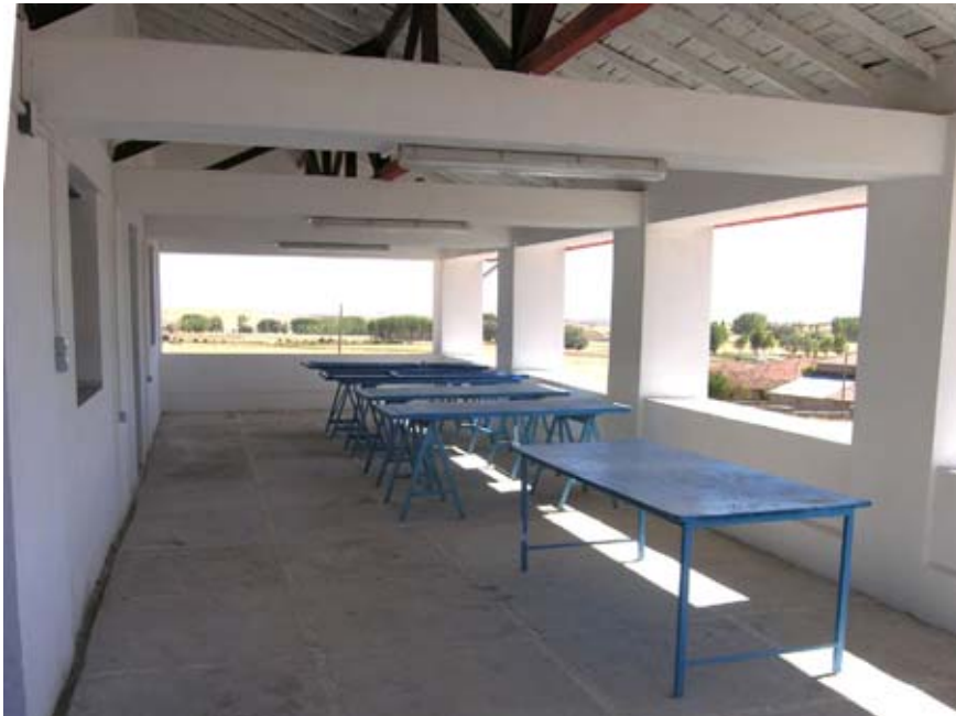
Şekil 16. Yapı, geniş bir işliğe ek olarak, taş mimari elemanların tasnif ve onarımı için masaların yerleştirilebileceği kapalı geniş bir terasa sahiptir. (07dpnc1031)
