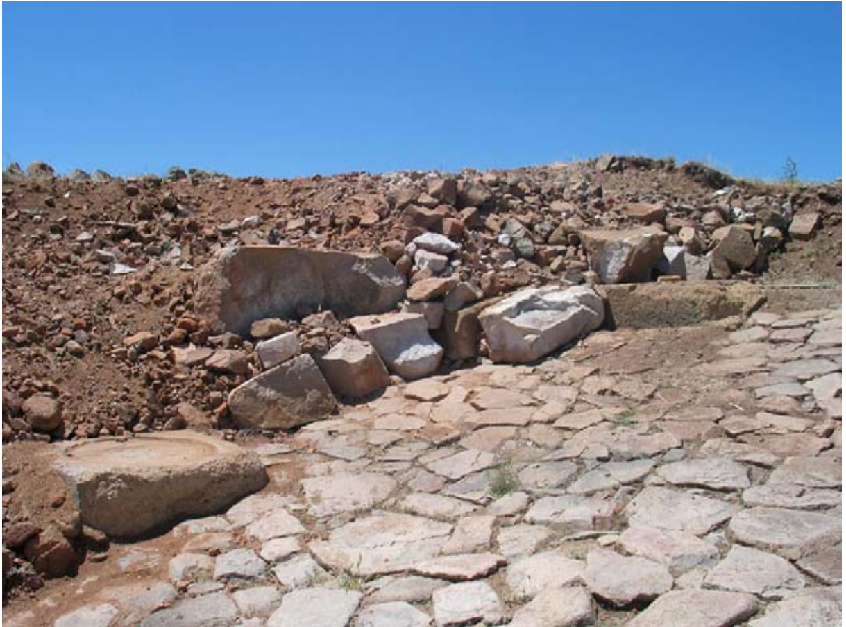
Şekil 37. Saray Yapı Grubunun Anıtsal Girişinde, yangın sonucu parçalanmış taş bloklar kenara çekilmiş ve teras duvarı çekirdeğini oluşturan moloz dolgu güvenlik nedeniyle tesviye edilmiştir. (07dpnc1748)
