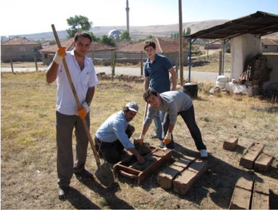
Şekil 6. ODTÜ Mimarlık öğrencileri güneşte kurutulmuş geleneksel kerpiç tuğla yapımını öğrendiler. (09kecp0714)
