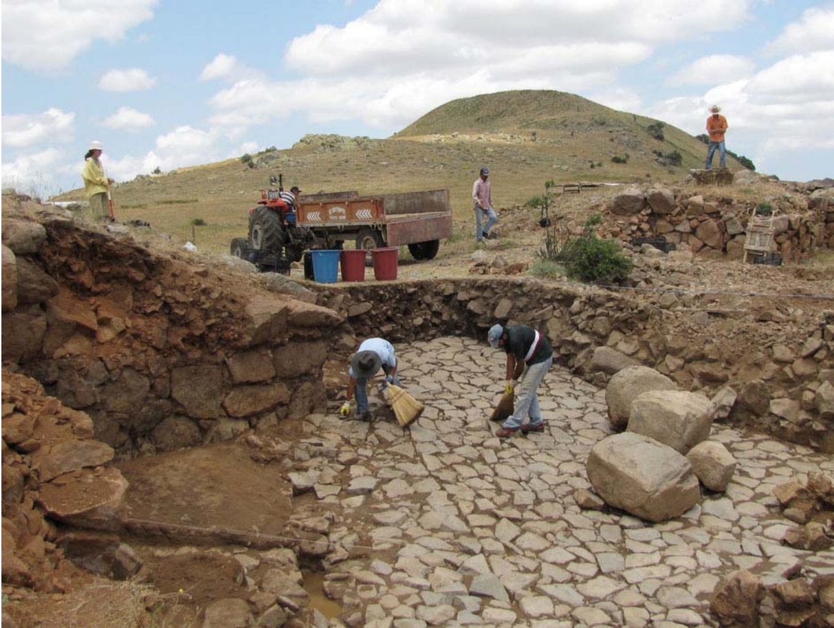
Şekil 39. Kapı Geçiti ve su kanalı temizlenirken. Solda, döşemenin üstündeki açık renkli killi tabakada açılan kesit, temizlik çalışmasından önce belgelenmiştir. (09dpcp0633)
