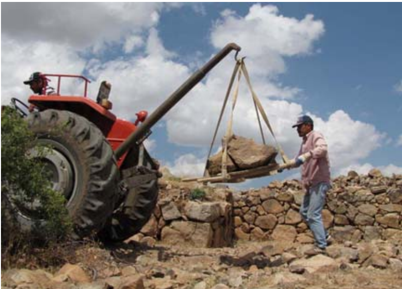
Şekil 29. Büyük taşların taşınma yöntemi. (09dpcp0509)
