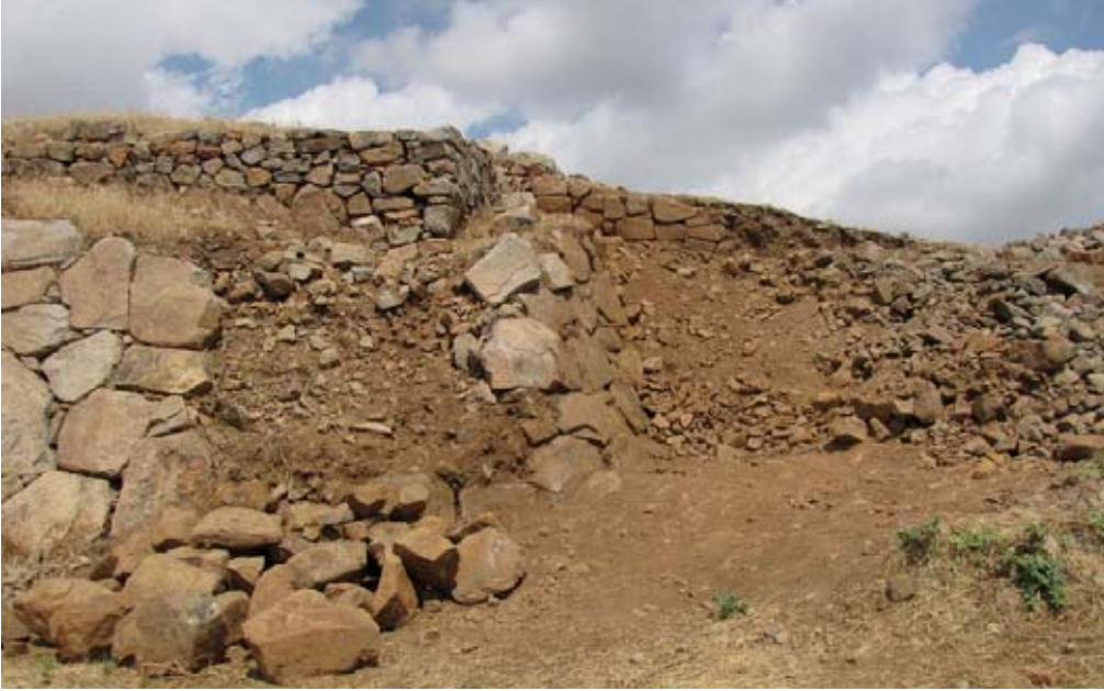
Şekil 32. Doğu Kule'nin güneydoğu köşesinde bulunan taş kaplı eğimli yüzeyin temelleri dışında tamamının tahrip olduğu anlaşılmıştır. (09dpcp1256)
