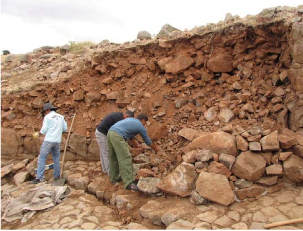
Şekil 30. Güneybatı duvarın gevşek dolgu yapısı yatay hatların kullanıldığı ön yüz çöktüğü zaman ortaya çıkmıştır. (09dpcp1619)
