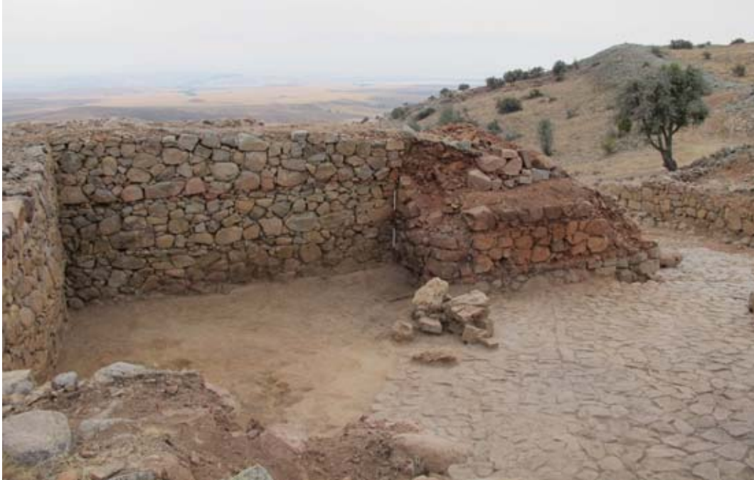
Şekil 125. Kumtaşı blokların düştüğü Orta Kule'ye bakış. Taş döşeme yolun çizgisine ve doğu eklentinin kavisli kenarına dikkat ediniz. (10dpcg0729)
