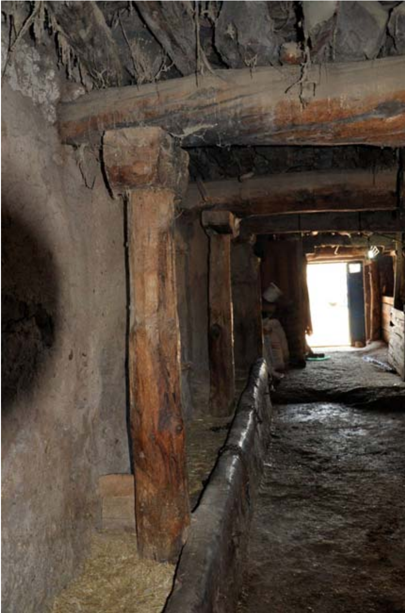
Şekil 64. Ahşap dikmeler, başlıklar ve çatı kirişleri ile çamur sıvalı duvar ve hayvan yemliklerinden detay. (10dpnd1907)
