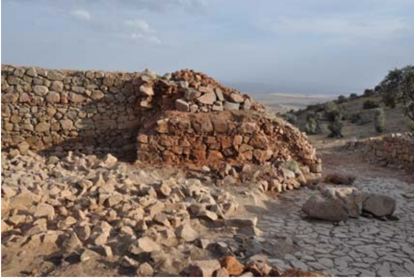
Şekil 99. Duvarın yapısal dayanıklılığındaki yetersizlik yatay ahşap hatılların yanmasından sonra oluşan boşlukların bir sonucudur. (10dpnd1390)
