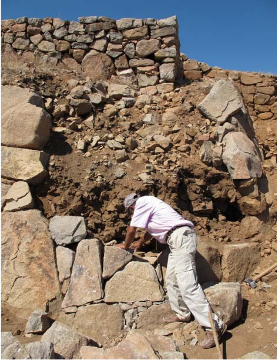
Şekil 139. Çok gevşek durumda olan moloz dolgu ve toprağın kaymasını önlemek adına, taş kaplı şevin restorasyonu elzemdi. (10dpcg0301)
