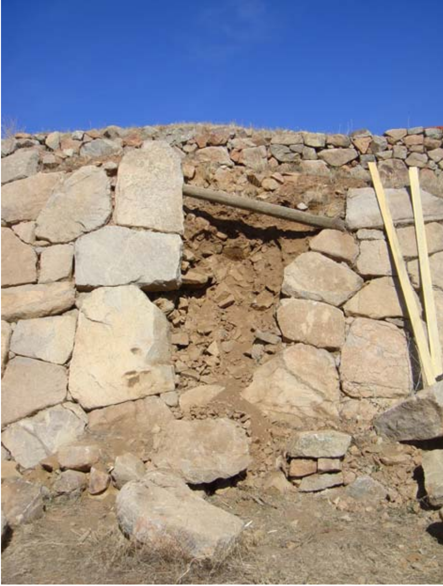
Şekil 141. Güneydoğu duvar yüzeyinden düşen büyük taşlar, 1999da çekilen fotoğraflardan tespit edilerek özgün yerlerine geri konulmuştur. (10dpkc3513)
