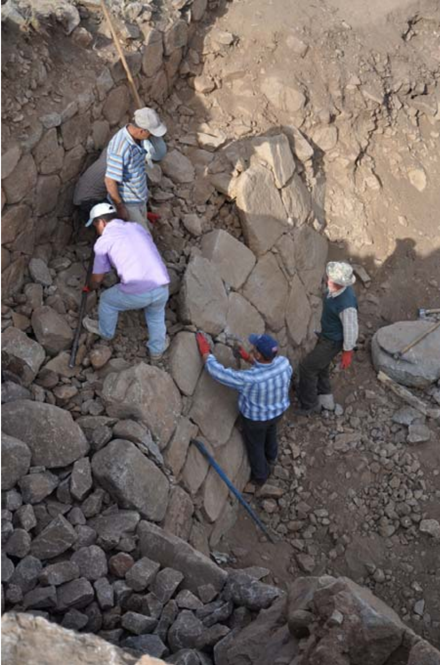
Şekil 151. Duvar ustaları, taş kaplı şevin geniş taşlarının arkasındaki boşluğu orta ve küçük boy taşlar ile doldurmuştur. (10dpnd1376)
