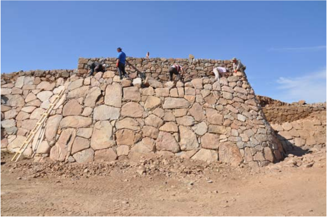
Şekil 148. Orta Kulenin önündeki iki büyük taş, özgün konumlarına yerleştirilince, taş kaplı şevin özgün yüksekliğinde yeniden inşa edilmesi mümkün olmuştur. (10dpnd1141)
