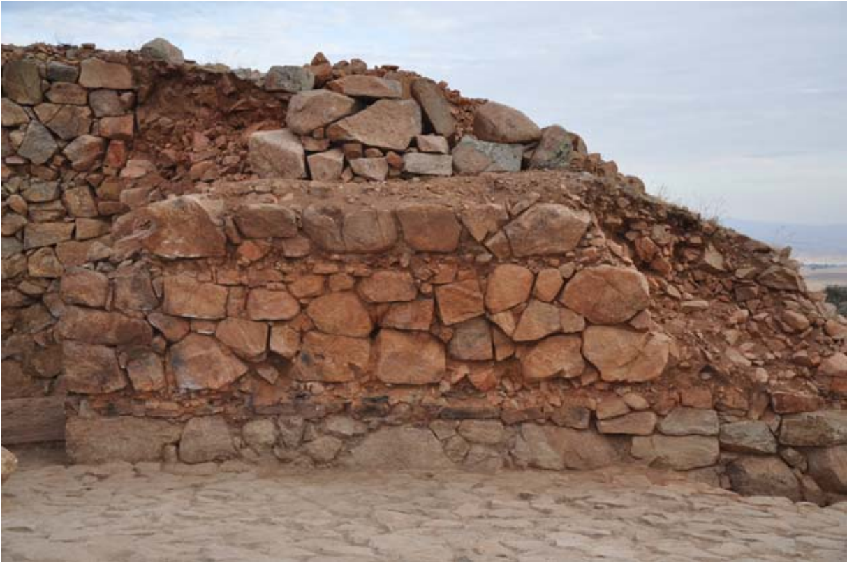
Şekil 106. Orta Kulenin çökmeden önceki iç yüzü, ahşap hatılların yerlerini ve yangının şiddetini göstermekte. (10dpnd2168)
