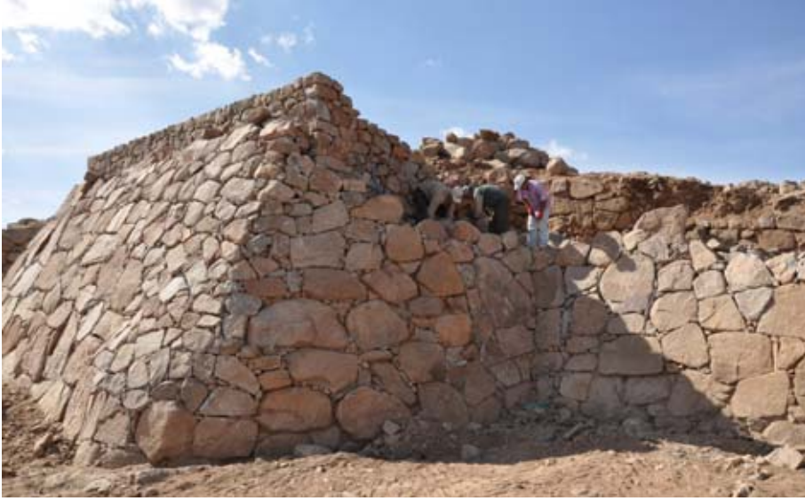
Şekil 153. Taş kaplı şev, Doğu Kulesi ve Şehir Duvarı kesişimi boyunca özgün yüksekliğinde yeniden inşa edilmiştir. (10dpnd1422)
