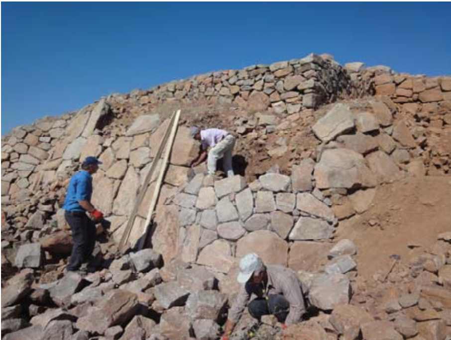
Şekil 140. Taş kaplı şevin doğu kesimi, öncelikli olarak restore edilmiştir. Böylelikle yapısal stabilite sağlanmış ve ileride gerçekleşebilecek başka çöküntüler engellenmiştir. (10dpkc3302)
