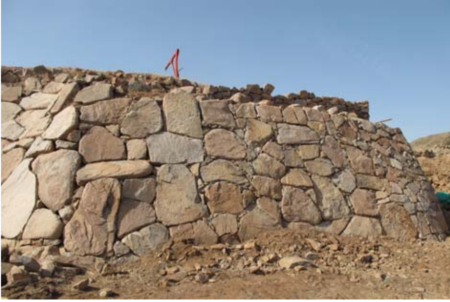
Şekil 143. Taş kaplı şevin doğu kanadı komşu uzantısının yüksekliğinde restore edildiği vakit, şevin üst tarafının yeniden inşasından önce, sol taraftaki yerinden kaymış iki kayanın özgün yerlerinin belirlenmesi gerekli görülmüştür. (10dpcg0318)
