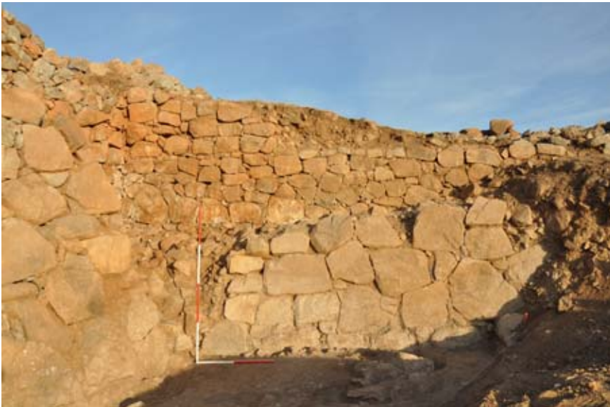
Şekil 115. Kazıların, taş kaplı yüzeyin sağlam kalan kısmını açığa çıkarmasından sonra, Doğu Kule ve bitişik Şehir Duvarının uzantısının kesişimi. (10dpnd1012)
