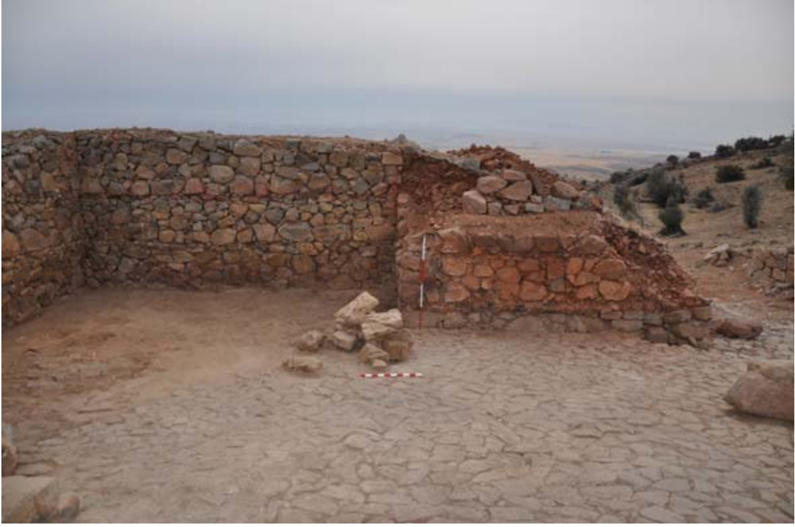
Şekil 100. Taş döşeme üzerine düşen kumtaşı bloklarının yeri dikkatlice kaydedilmiştir. (10dpnd2204)
