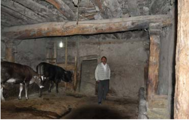
Şekil 66. Kara Mehmet Şahmuratlı Köyü'nde bugün büyükbaş hayvan ahır olarak kullanılan eski ahırında. Merkezi bir akaç, beton zemin boyunca uzanırken; yemlikler iki yanda hizalanmıştır. Sondaki kapı, kuru yem deposuna açılmaktadır. Günümüzde civarda mevcut olmayan çatı kirişlerinin boyutu dikkate değerdir. (10dpnd1904)
