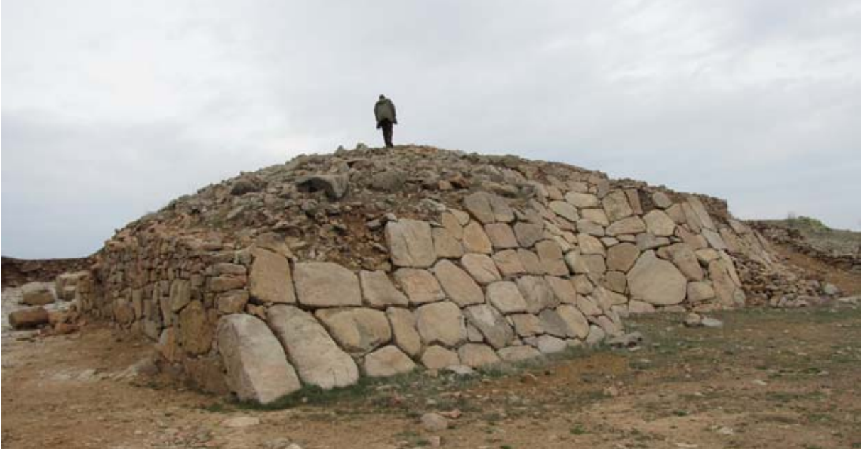
Şekil 126. Mayıs 2010da restorasyon çalışmaları öncesi fotoğraflanan Kapadokya Kapısı'nın taş kaplı şevi. (10dpcp0118)
