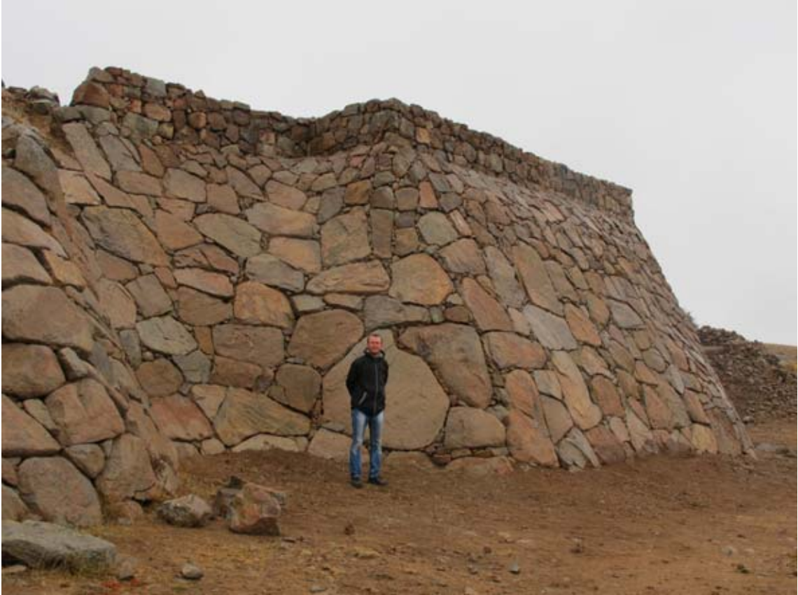
Şekil 135. Yetenekli beş duvar ustasından oluşan ekibiyle Erkan Kambek, çalışmasını bir aydan daha kısa bir sürede tamamlamıştır. (10dpcg0761)
