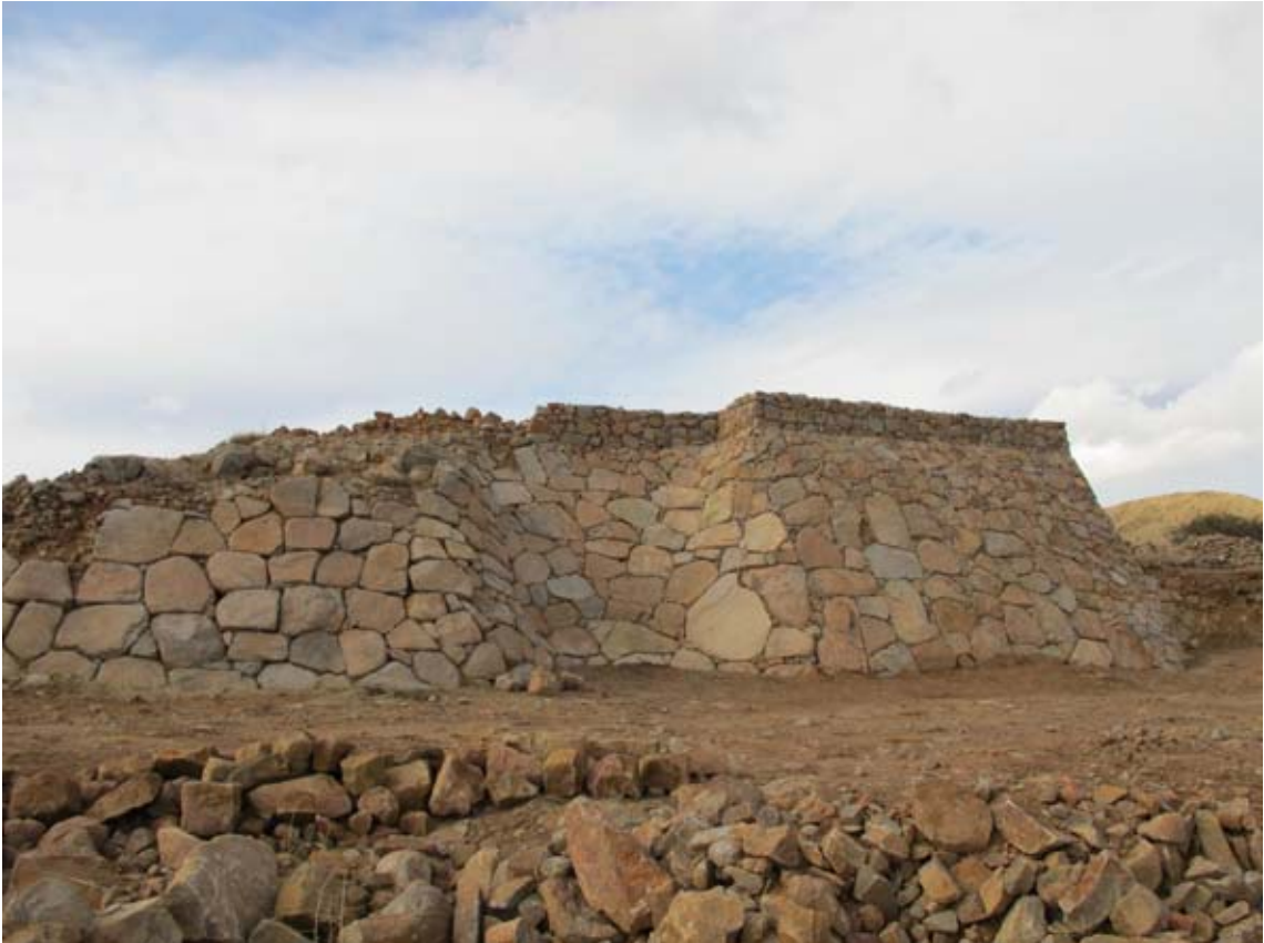
Şekil 132. 2010 Restorasyon çalışmaları sonunda Kapadokya Kapısı taş kaplı şevi. (10dpcg0935)
