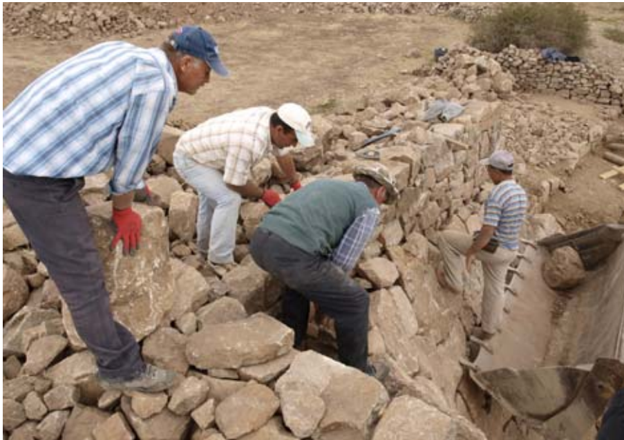
Şekil 133. Doğu Kule'nin güvenli bir şekilde güçlendirilmesinden sonra, geniş şehir duvarını kendi temeli üzerinde yükseltmek mümkün olmuştur. (10dpkc2505)
