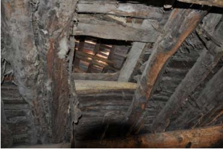
Şekil 65. Özgün düz çatı, kırık dallar ve kalın bir tabaka çamurla kaplı mertegi destekleyen kalaslar ile inşa edilmiştir. Özgün çatıya açılmış olan tavan kapısı, sonradan eklenmiş kil tuğladan beşik çatıya küçük bir bakış sağlamaktadır. (10dpnd1905)
