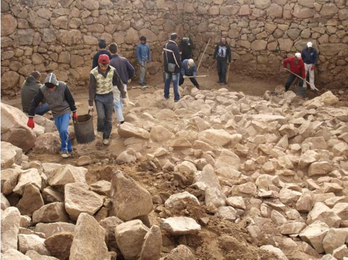
Şekil 94. Kapı Avlusunda düşen taşların sonuncularının temizlenmesi. (10dpkc2227)
