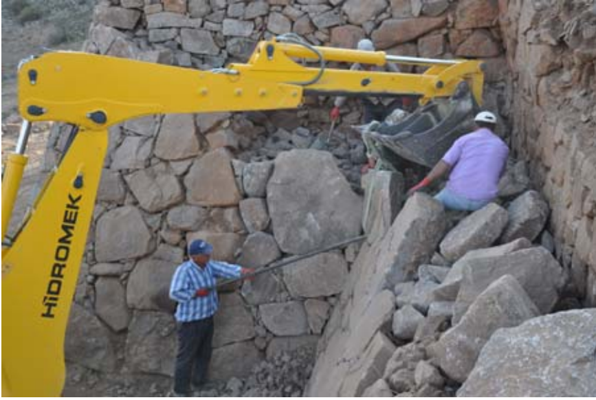
Şekil 150. Ağır vasıtanın kepçesi, büyük ve ağır taşların kaldırılmasında kullanılmıştır. (10dpnd1395)
