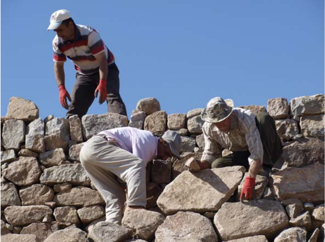
Şekil 149. Taş kaplı şevin dik duvar ile birleştiği yerde boşluğa uyabilecek taşlar özenle seçilmiştir. (10dpkc1936)
