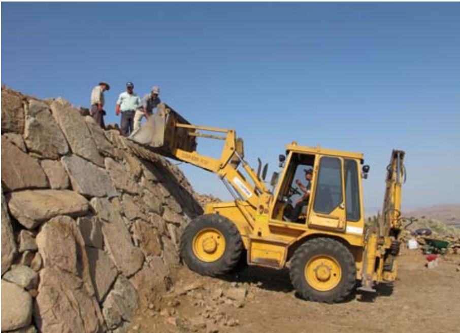
Şekil 142. Ağır vasıtanın kepçesi, inşaat iskelesinin başarılı bir vekili olmuştur. (10dpcg0328)
