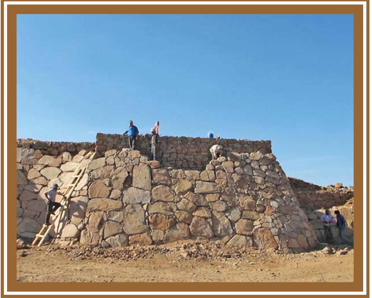
Şekil 1. Kapadokya Kapısı'nın taş kaplı şevi restorasyon aşamasında. (10dpcg0425)
