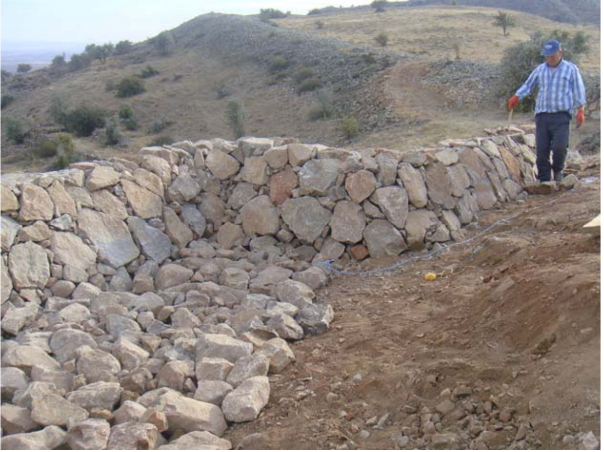
Şekil 155. Güvenlik tedbiri olarak ziyaretçilerin kenara fazla yaklaşmasını engellemek adına, restore edilmiş duvarlar, korkuluk oluşturacak şekilde yükseltilmiştir. (10dpkc3942)
