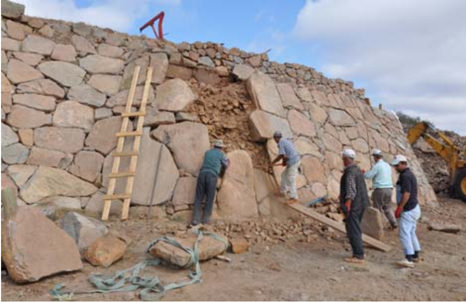
Şekil 144. Makine operatörü yukarıdaki taşları başarıyla kaldırarak yere indirmiştir. Dışarı kayan geniş taş yerine itilerek, taş kaplı şevin hizasına getirilmiştir. (10dpnd0848)
