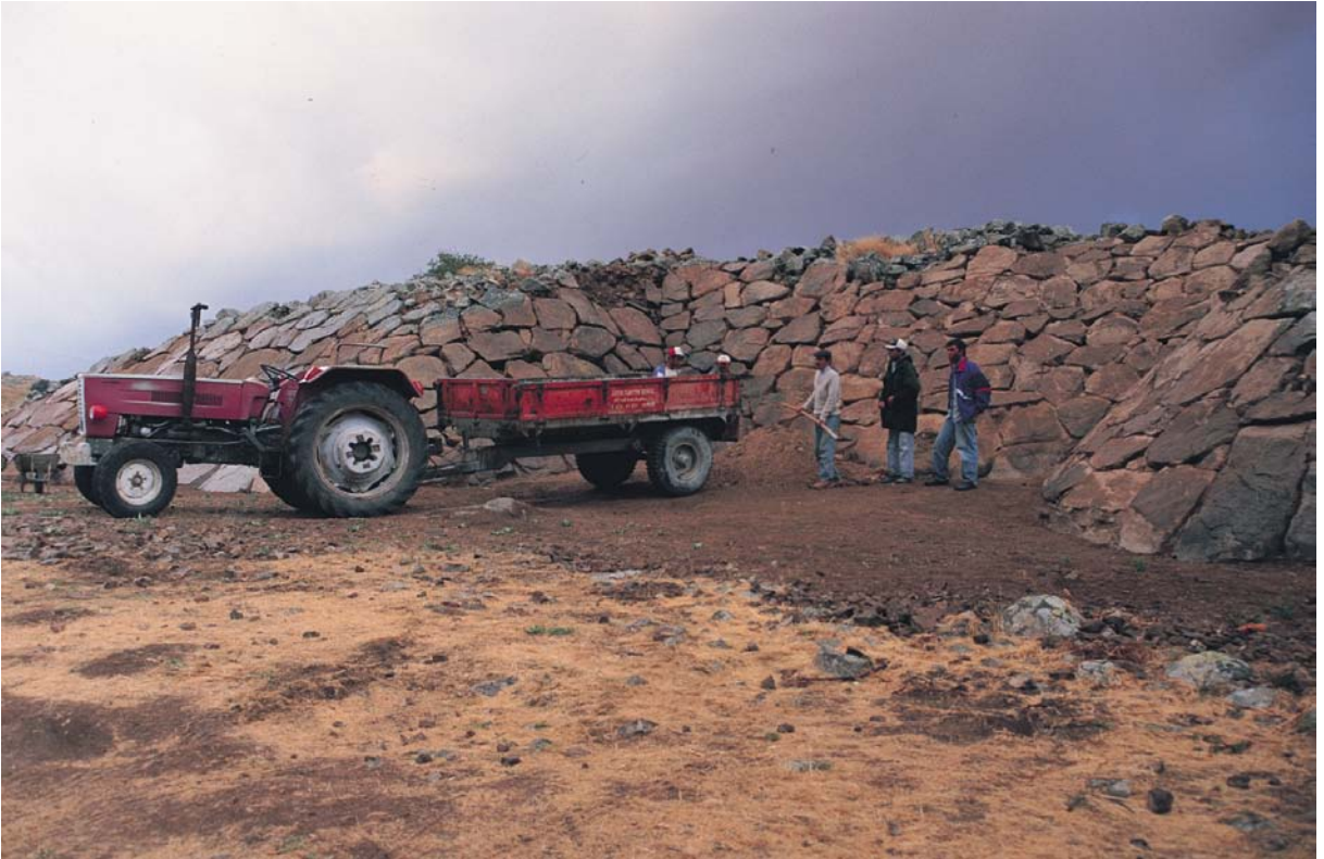
Figure 38: "Saray Yapı Grubu" nun eđimli tađ kaplı yüzeyinin önündeki zemini temiz bir toprak tabakası kaplanarak korunmuştur.
