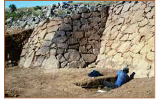
Figure 12: Buttress, with burning stains, and part of the glacis. Şekil 12: Üzerinde yangın izleri görülen payanda ve eğimli taş yüzeyin bir bölümü.
