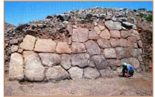
Figure 13: Glacis of the South-East Tower of the gate with burning stains. Şekil 13: Kapının Güneydoğu Kulesinin eğimli taş yüzeyi. Eğimli taş yüzeyin üstünde yangın izleri görülebilmektedir.
