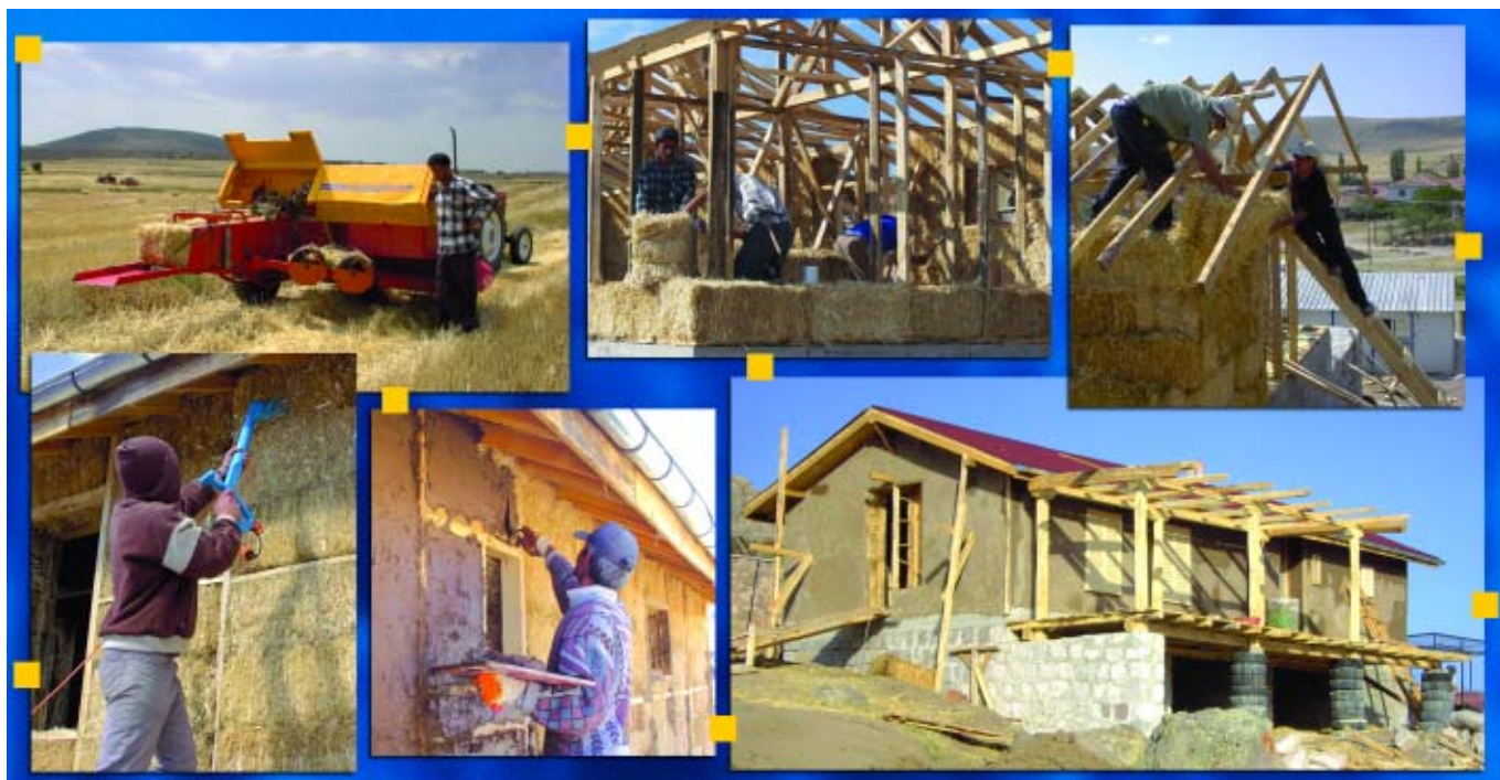
Figure 22. Steps showing the straw from the field to the walls. Strawbale walls are coated with a mud plaster. Pekil 22. Samanın tarladan duvara kadar geçirdiği aşamalar. Saman balyası duvarlar kerpiç sıvayla kaplanmıştır.
