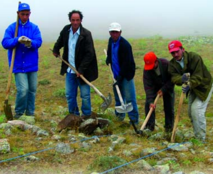
Starting test trenches for the GIS transportation studies. CBS Ulaştırma Çalışmaları için test açmasına başlarken.
