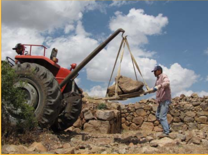
Figure 12. One way of moving large stones. Şekil 12. Büyük taşların taşınma yöntemlerinden biri.
