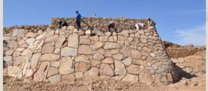
Cappadocia Gate restoration in progress Kapadokya Kapısı restorasyon çalışması
